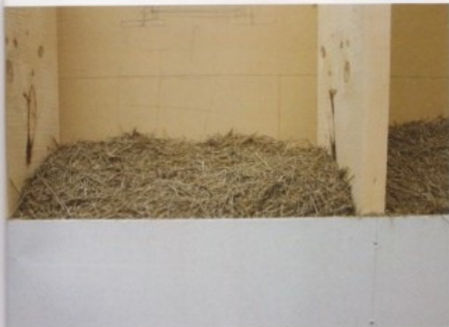
Pour être performante, la paille de lavande doit être posée en épaisseur importante, ici 30 cm pour les murs et 40 cm en toiture.
