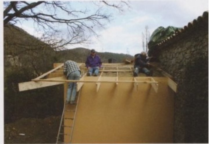
La paille de lavande concassée est légèrement tassée dans les caissons verticaux qui sont composés par l'ossature bois et les panneaux de Fermacell à l'intérieur et d'Agepan à l'extérieur.
