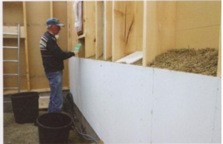
La paille de lavande concassée est légèrement tassée dans les caissons verticaux qui sont composés par l'ossature bois et les panneaux de Fermacell à l'intérieur et d'Agepan à l'extérieur.
